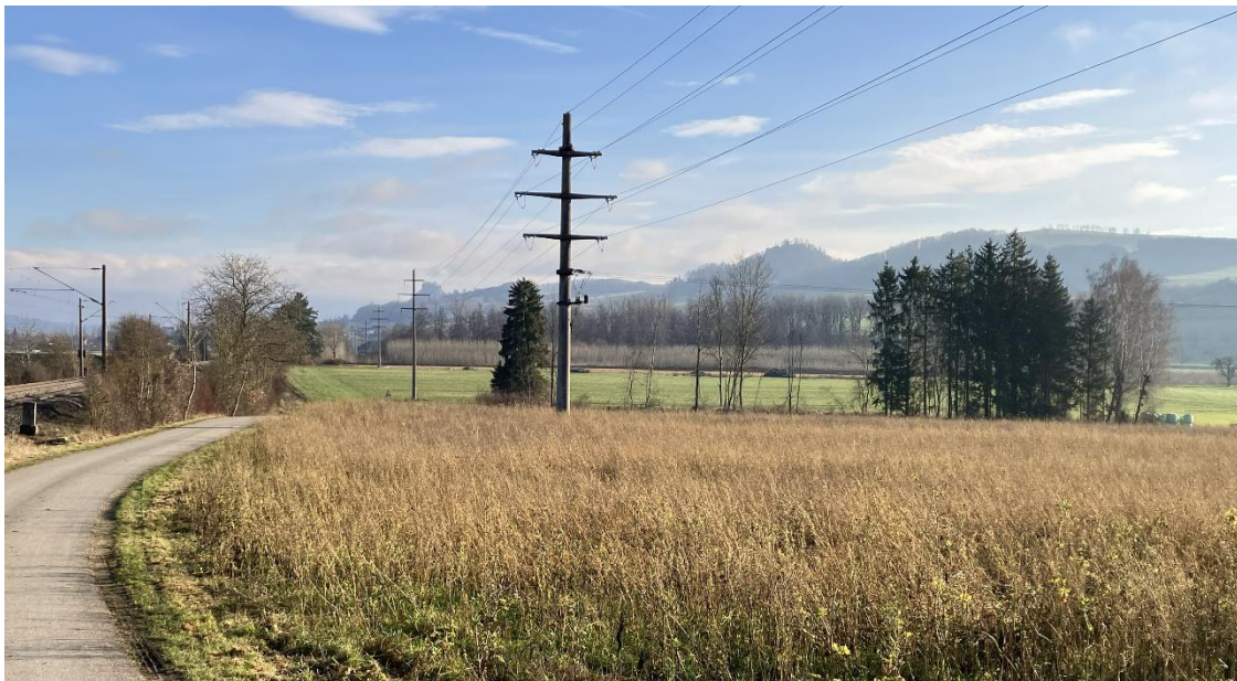
Blick von Nordwesten von der Bahnüberführung nach Osten auf das tieferliegende Plangebiet (Grünland im Hintergrund). Landschaftliche Vorbelastungen bestehen in der Freileitung sowie dem Bahndamm (links im Bild). Die Fichtengruppe rechts im Bild wächst an der Tümpelquelle.
