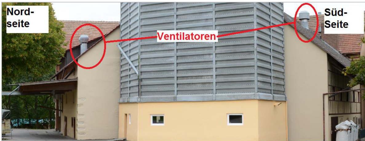
Abbildung 8: Standort der Ventilatoren auf dem Dach des Mühlegebäudes
