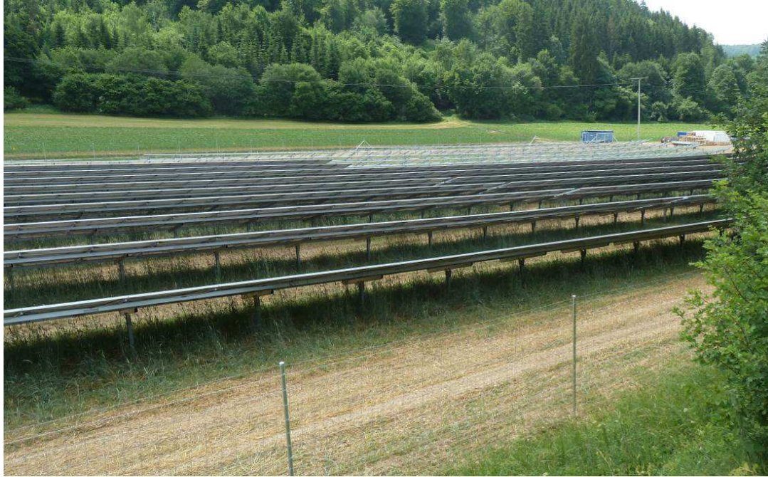
Abb. 6: Beispiel einer Freiflächen-Photovoltaikanlage in Storzingen (Fläche rd. 1,3 ha, Leistung 750 kW, Betreiber: Solarcomplex)
