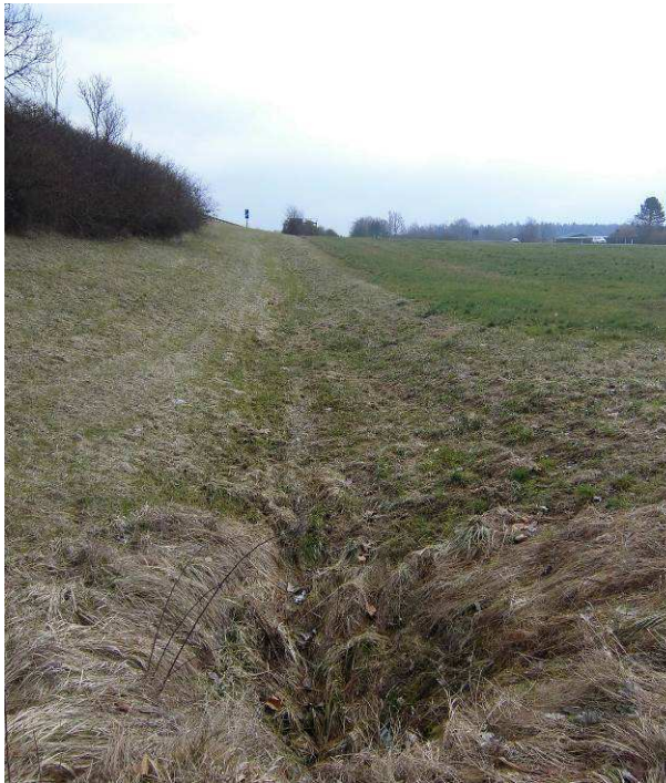
Blick entlang Autobahnböschung nach Osten. Geschützte Feldhecke, Extensivgrünland und Durchlass.
