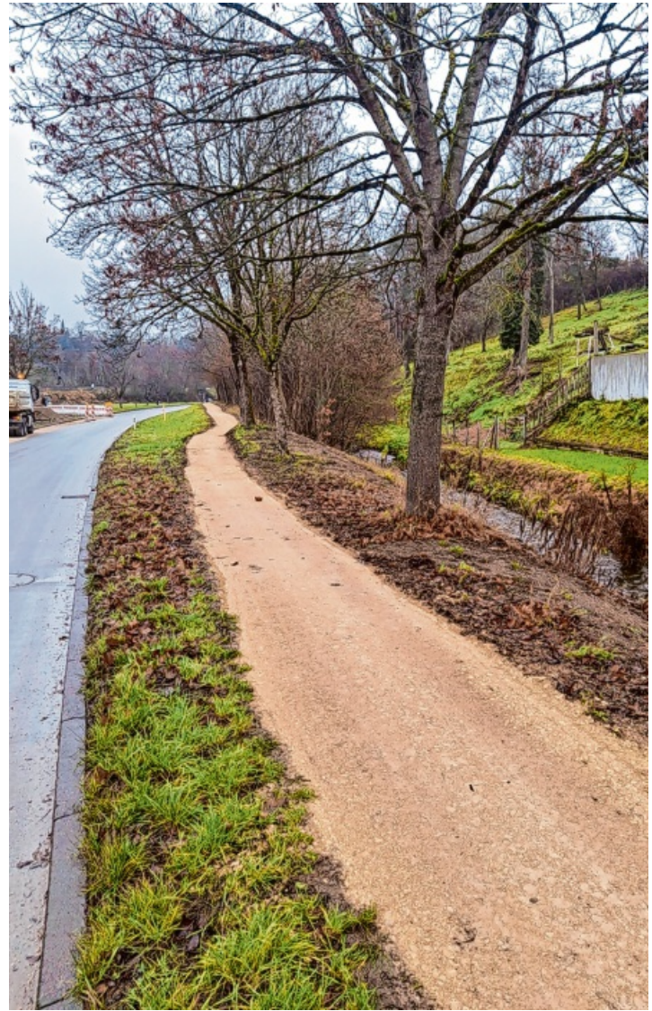
Ein kurzer Abschnitt des Fußweges zwischen Engen und Neuhausen wurde verbreitert. Der Weg zwischen Bach und Landesstraße konnte durch die geringe zur Verfügung stehende Fläche nur auf eine Breite von circa 1,5 Meter ausgebaut werden. Bild: Stadt Engen
