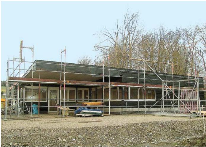
An der Baustelle für den neuen Eingangs- und Umkleibereich vom Erlebnisbad Engen geht es mit Riesenschritten voran. Das neue Kioskgebäude steht bereits, und gleich nach der Fasnacht wird auch der Umkleibereich in Abschnitten gestellt. Im neuen Kiosk werden zurzeit die Installationen verlegt, mit dem Innenausbau wurde begonnen. Bild: Stadt Engen
