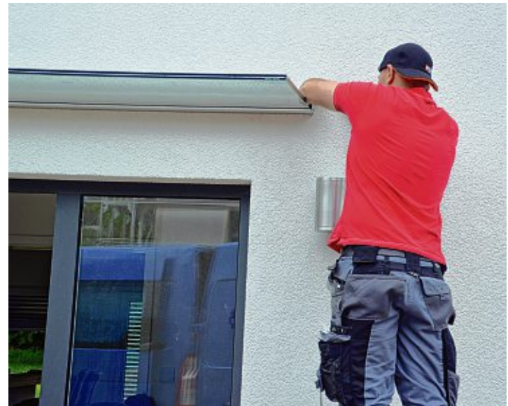
Fachgerecht und zügig erledigen die Monteure von Schelle die Arbeiten.
