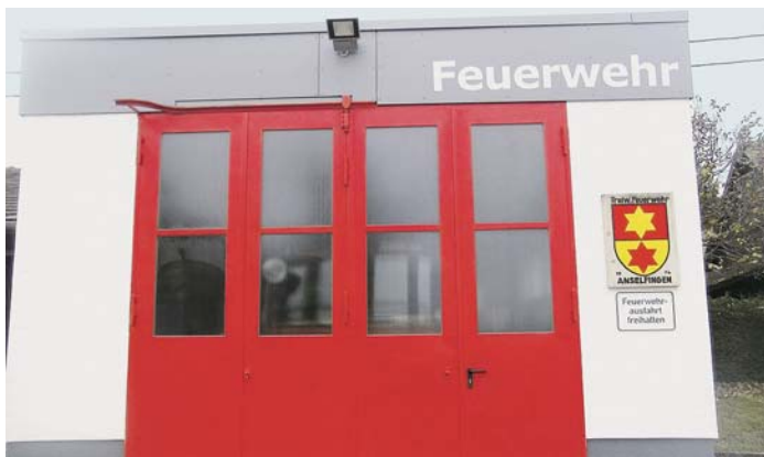
Das Gerätehaus Anselmingen erstrahlt dank des Engagements der Feuerwehrmänner in neuem Glanz.
