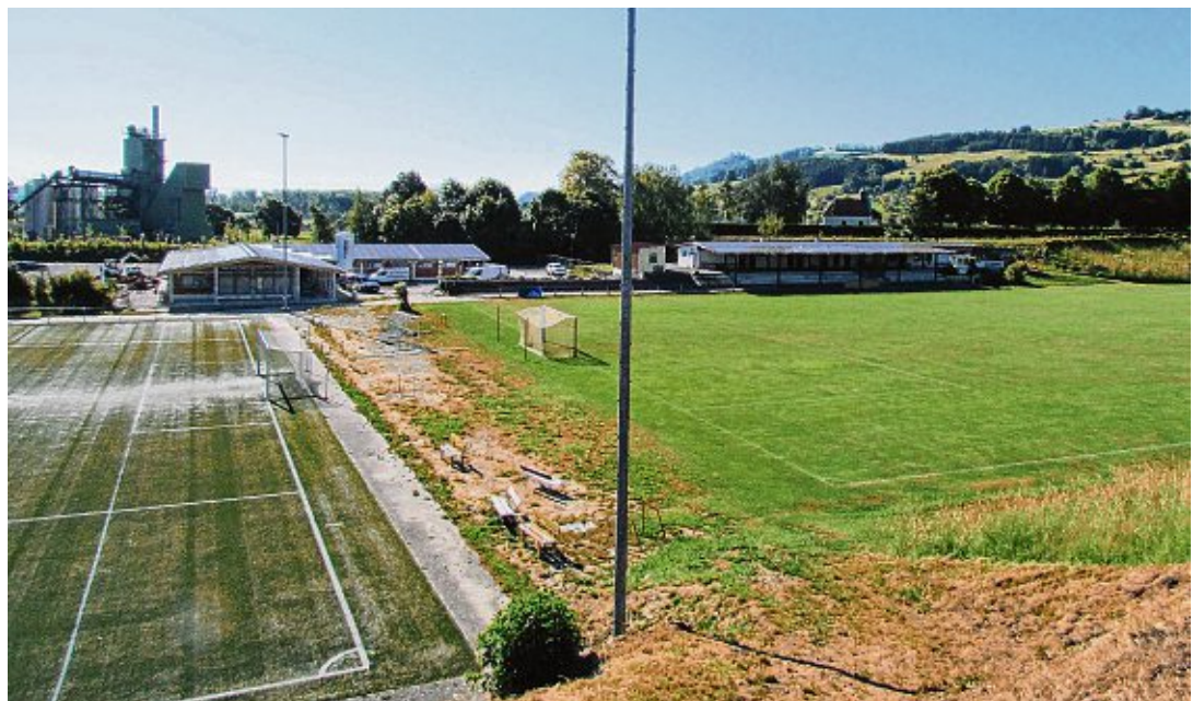
Das neue Clubheim des Hegauer FV (linkes Gebäude) geht der Fertigstellung entgegen. Nach dem Abriss des alten Clubheims (rechtes Gebäude) sollen die Sportflächen neu angelegt werden.
