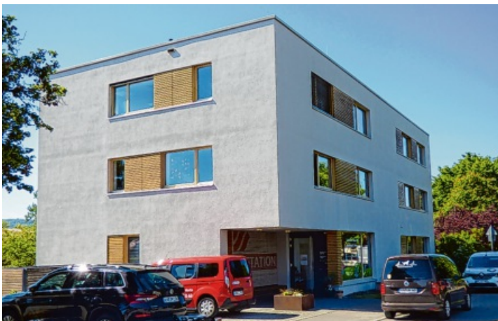
Markant steht die aktuelle Heimat der Sozialstation am Pfarrer-Adler-Platz. Bilder: Durlacher
