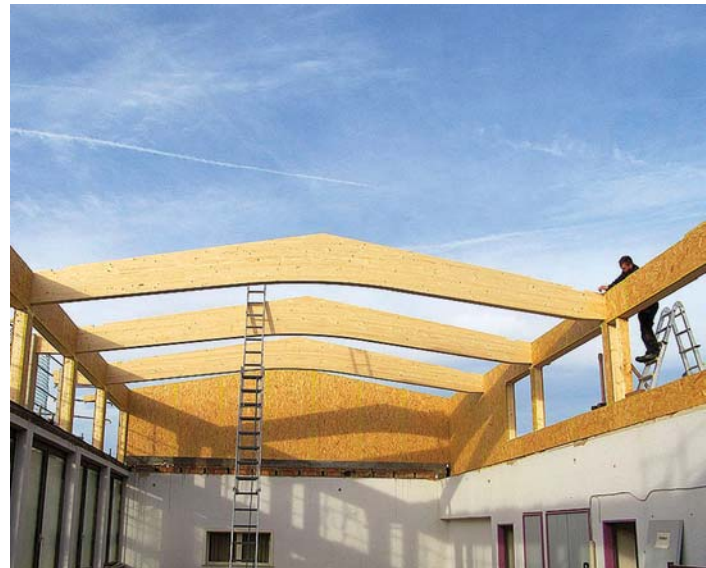
Die Umbauarbeiten an der Petersfelshalle in Bittelbrunn sind vorangeschritten. Die Erhöhung der Wände wurde bereits montiert und die neuen Binder werden aufgelegt. Bild: Stadt Engen
