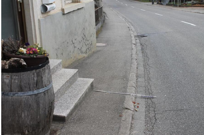
Abbildung 13: Engstelle Gehweg 0,60 m
